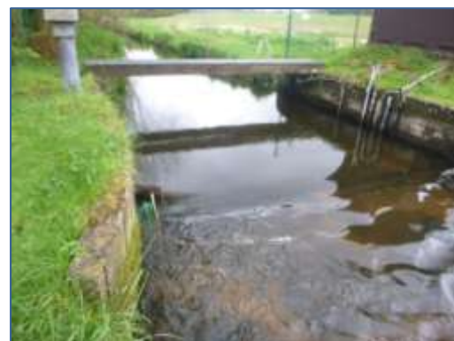
Vue de la prise d'eau destinée à l'alimentation en eau potable et de la station de jaugeage localisée immédiatement en amont.
