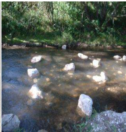
Exemple de travaux réalisés sur la Brenne (37) – Photos : Fabien Languille : déflecteurs en bois, dispersion de blocs sur un radier, création d'un mini-seuil
