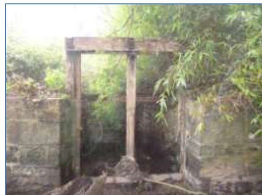
Vues de du bief de Pen Enez au moulin et de la vanne de décharge (pertuis libre).
