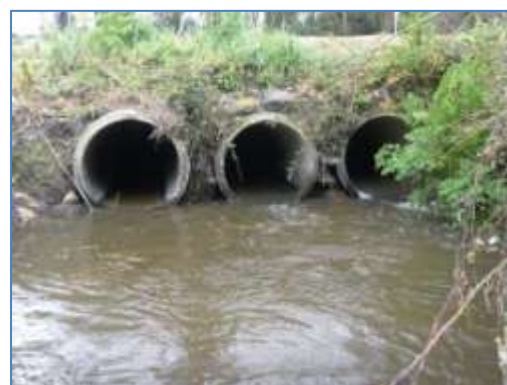
Vue aval des buses de la route de Kerganet (aval Quélordan) devant faire l'objet d'une recharge granulométrique aval.
