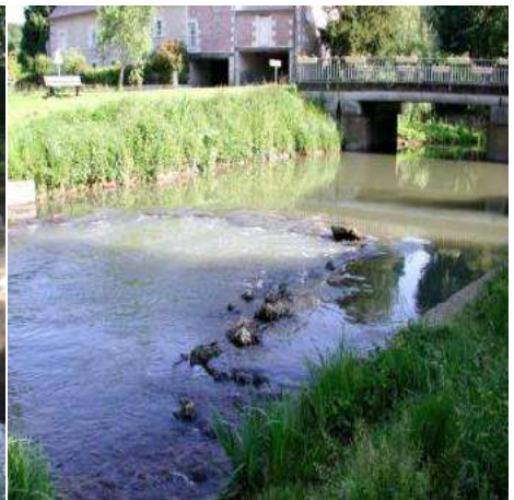
Exemple de travaux réalisés sur la Brenne (37) – Photos : Fabien Languille : déflecteurs en bois, dispersion de blocs sur un radier, création d'un mini-seuil
