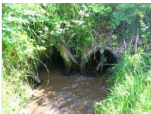
Vues du passage busé de la route de Kerbréc'h de l'amont (deux buses de diamètre 400 mm) et dalot partiellement effondré en aval.
