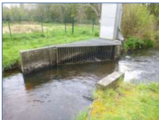
Vue de la prise d'eau destinée à l'alimentation en eau potable et de la station de jaugeage localisée immédiatement en amont.
