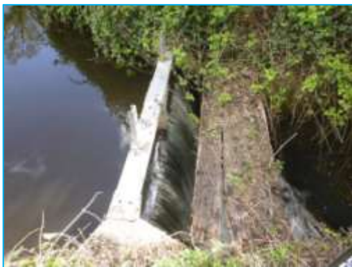
Vues du vannage et de la passe à poissons.
