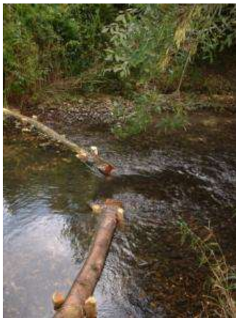
Exemple de travaux réalisés sur la Brenne (37) – Photos : Fabien Languille : déflecteurs en bois, dispersion de blocs sur un radier, création d'un mini-seuil
