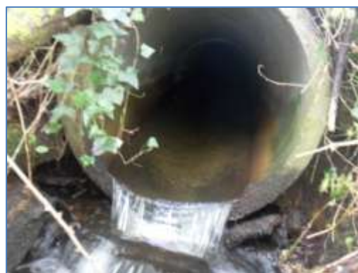
Vue de la buse de la route de Pont l'Abbé devant faire l'objet d'une recharge granulométrique aval.
