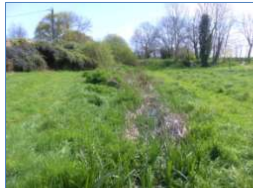
Vues du cours rectifié du ruisseau avec le calage du profil en long sur la partie aval du tracé par le passage busé de la route de Kermorvan.
