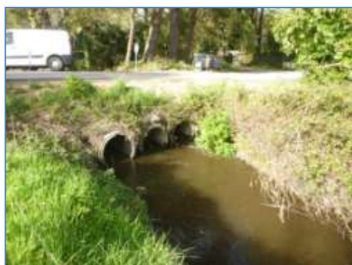
Vue aval des buses de la route de Kerganet (aval Quélordan) devant faire l'objet d'une recharge granulométrique aval.
