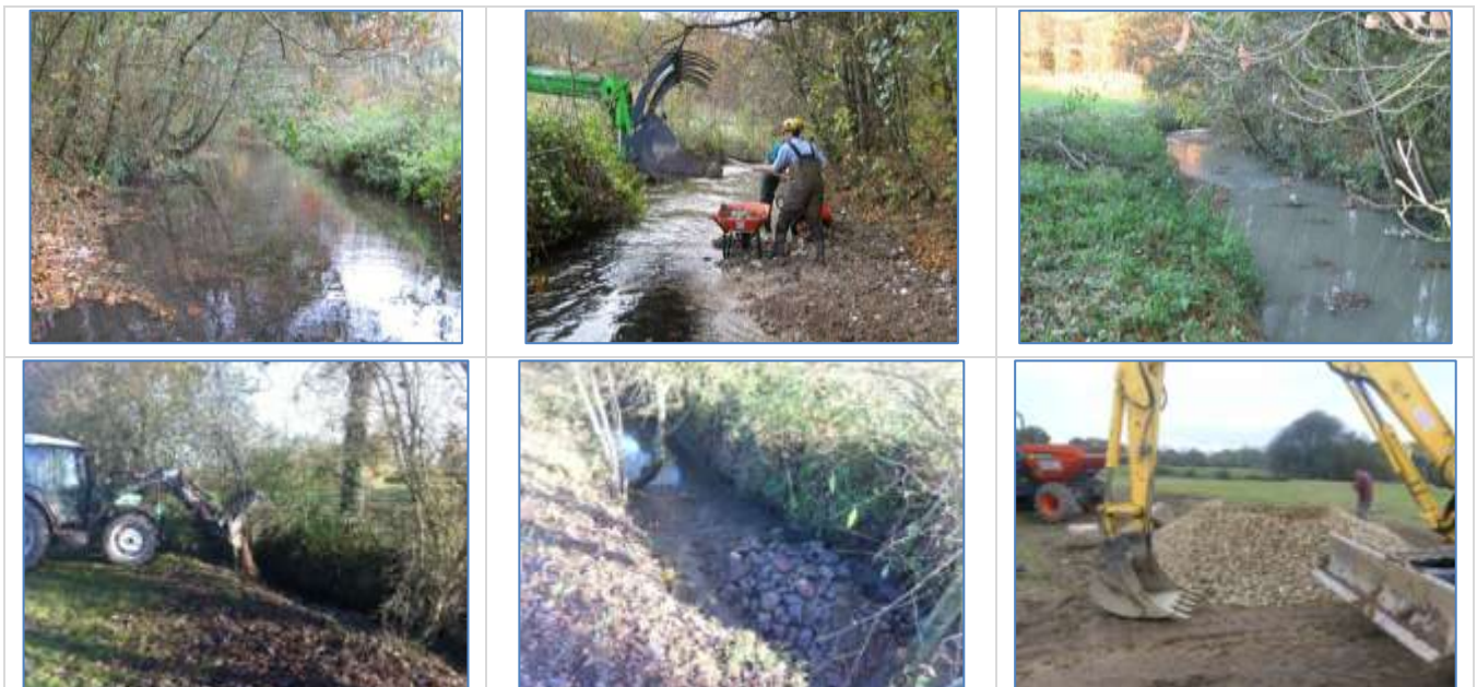
Exemple de recharge en granulats par banquette sur la Remberge (37) – Photos : Fabien Languille et sur la Sèvre nantaise amont (Serama)
