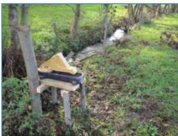
Exemple de pompe de prairie sur zone stabilisée installée en bordure d'un cours d'eau.
