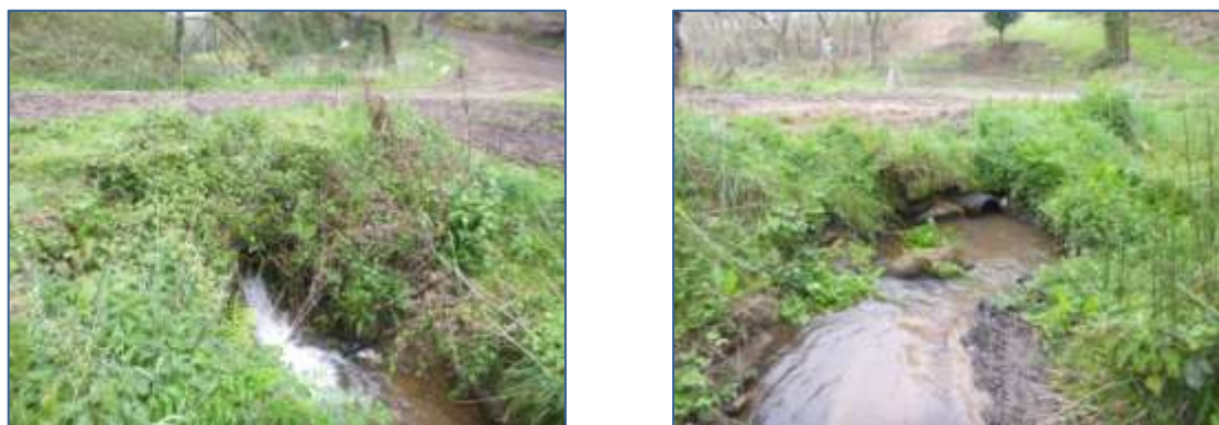
Vues de la buse depuis l'aval et de l'amont.
